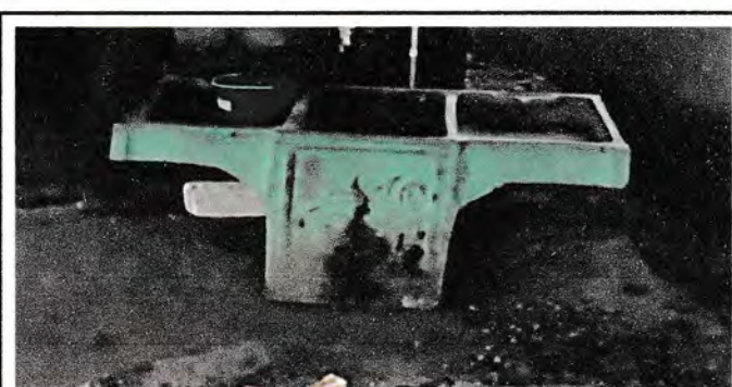
Foto 6: Pila en mal estado se le sale el agua porque esta gretada
