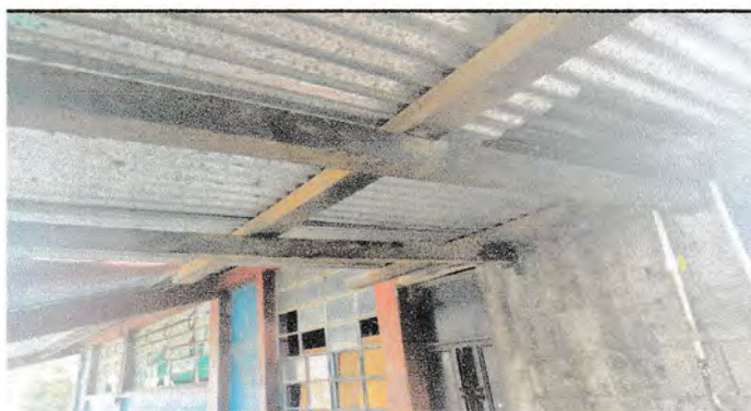
Foto 10: Reparación de techo de madera de galera de pila ya que estan picadas. Medidas de 3 metros de ancho por 6 de largo
