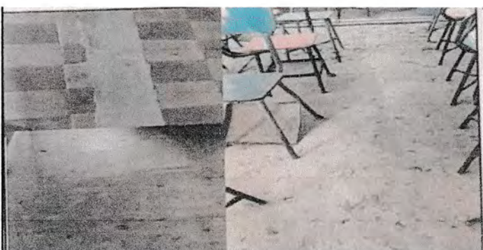
Foto 5: Sustrucción de piso, aula de 6 metros de ancho por 5 metros de largo
