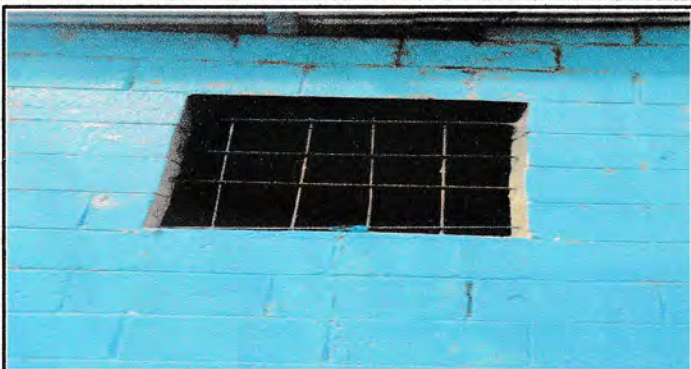
Foto7: Sustrucción de balcon de la cocina con medidas de 85cm. De alto por 82 de largoy colocación de vidrios
